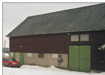
Takrenovering. Det gamla eternittaket skrapades och spolades med högtrycksspruta. "Ångan från det varma vattnet fick grannarna att tro att det brann!", berättar Martin Wentzel.
