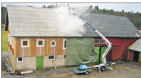
Takrenovering. Det gamla eternittaket skrapades och spolades med högtrycksspruta. "Ångan från det varma vattnet fick grannarna att tro att det brann!", berättar Martin Wentzel.
